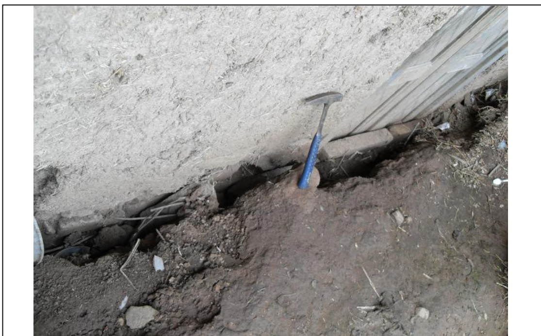
FOTO Nº 09 : Vista del frontis de una de las viviendas afectadas, donde se aprecia que estas se están asentando, generando inestabilidad en la cimentación y homogeneidad de las mismas.
