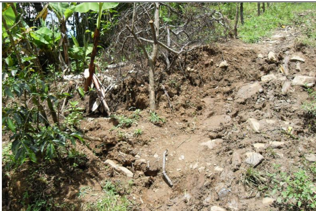
FOTO N° 01 : Vista de los asentamientos que se presentan en la parte baja del caserío El Potrero, apreciándose la heterogeneidad del conglomerado.
