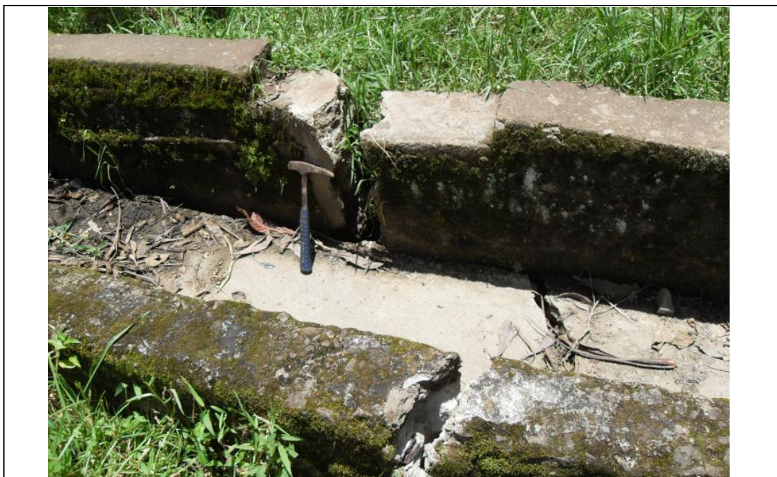
FOTO Nº 08 : Vista de la afectación al canal de regadío local, que por los asentamientos diferenciales pronunciados y el tiempo de vida útil de dicho canal, este ha colapsado, fracturándose y provocando la saturación del suelo de fundición.
