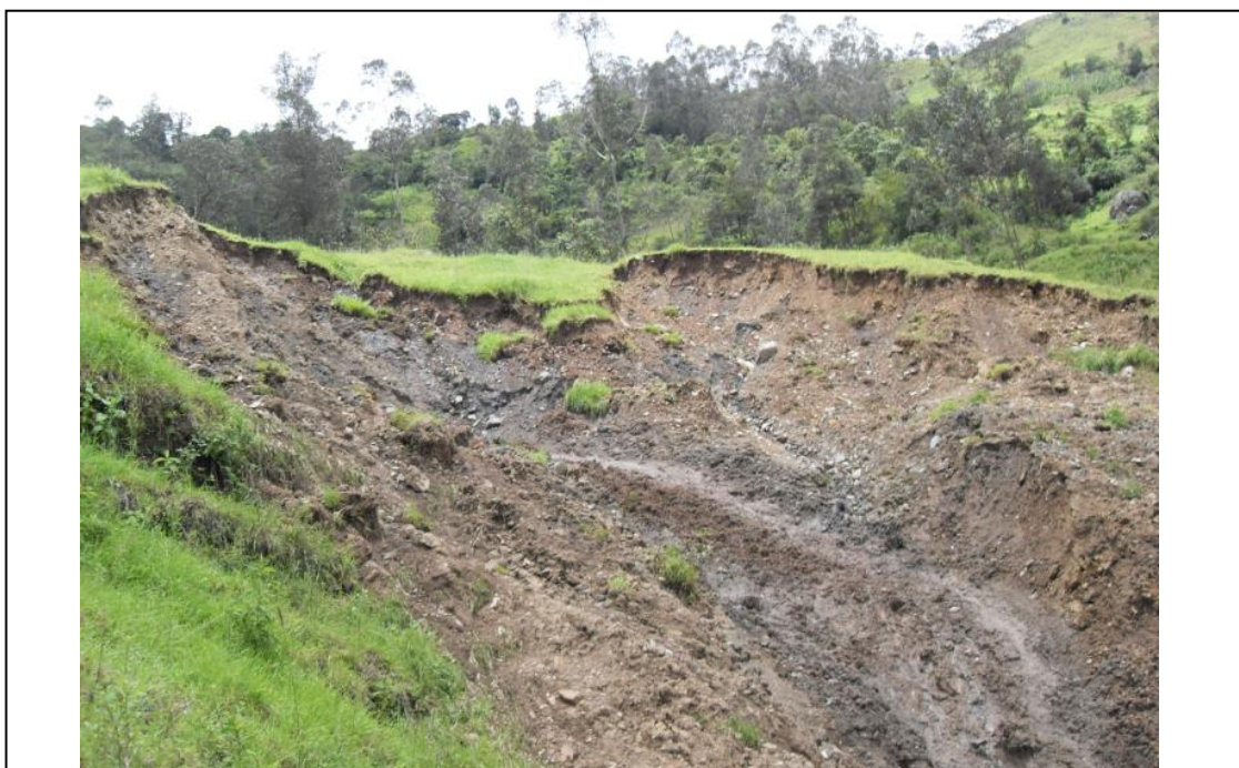
FOTO N° 11 : Vista del acercamiento del escarpe principal, donde se aprecia la definición de la cuña del macizo que ha cedido, generándose también flujos menores de lodo.
