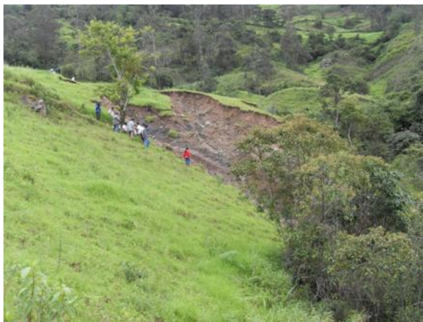
Figura 04. Parte superior material que se mueve a lo largo del contacto entre el Material perturbado y el escarpe principal.
